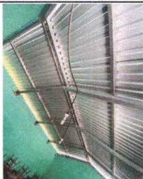
Foto 13: Sustrucción del cableado de energía eléctrica del aula 5
