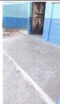
Foto 16: Sustrucción de piso de torta por piso cerámico del corredor del aula 1
