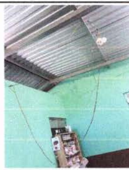
Foto 12: Sustitución del cableado de energía eléctrica del aula 3
