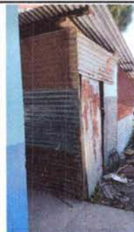
Foto 18: Reparación de bodega
