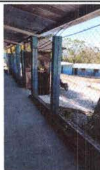
Foto 17: Sustrucción de malla perimetral por muro perimetral de las aulas: 1, 2 y 3
