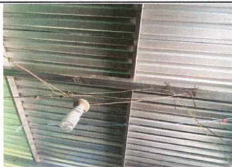
Foto 11: Sustitución del cableado de energía eléctrica del aula 2
