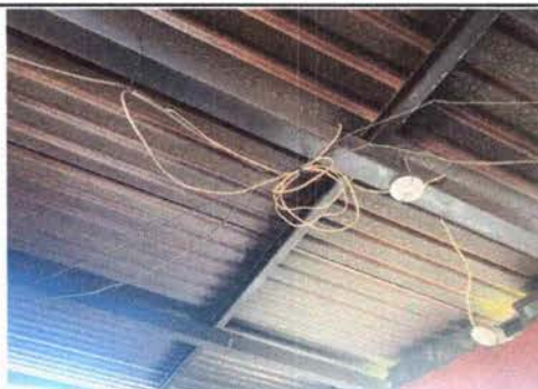
Foto 15: Sustrucción del cableado de energía eléctrica de la cocina
